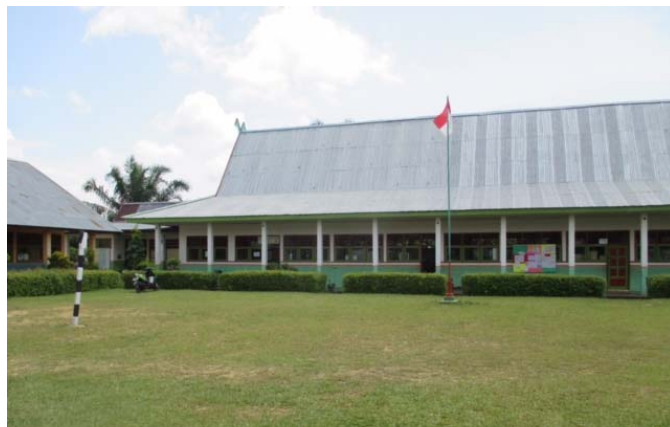
Tampak muka SDN 169/V Desa Cinta Damai. @Tanoto Foundation 2017.
